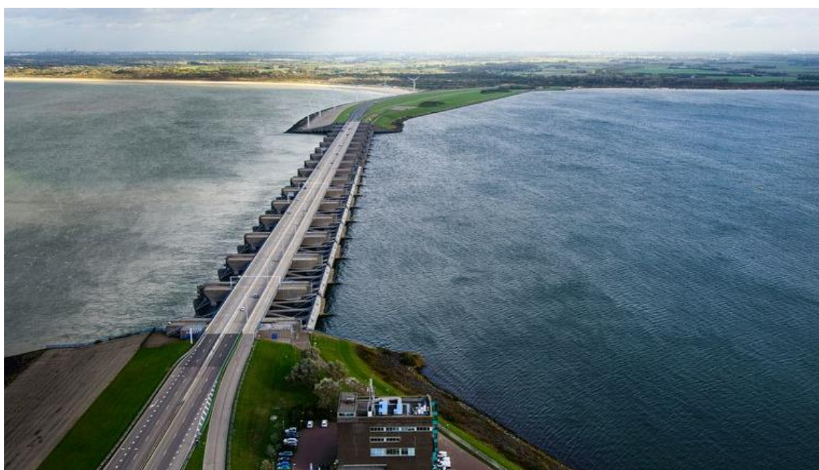
Figuur 1 Spuisluizen van de Haringvlietdam met aan de linkerkant de Voordelta en aan de rechterkant het Haringvliet (Swart, 2020)
